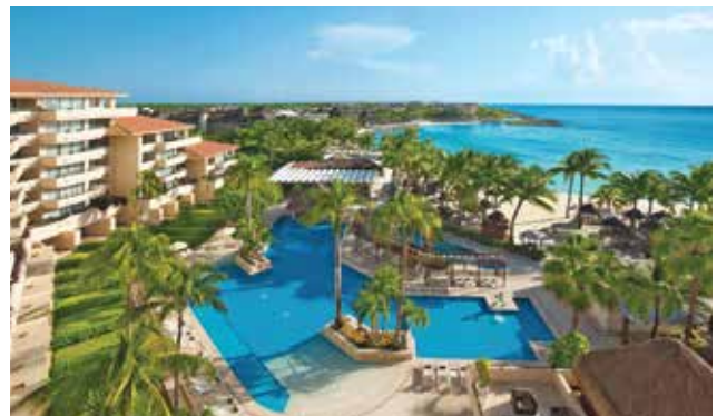
Công trình cáp ngầm Resort. Underground cable application for urban zones.
