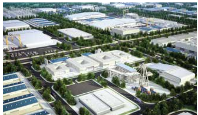
Công trình cáp ngầm tại nhà máy khu công nghiệp. Underground cable application for factories and industrial zones.
