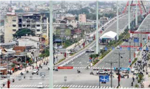
Công trình cáp ngầm hệ thống chiếu sáng công cộng. Underground cable application for public lighting.
