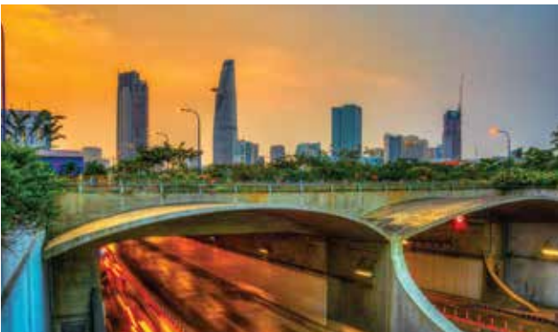
Công trình cáp ngầm đường hầm. Underground cable application for tunnels.
